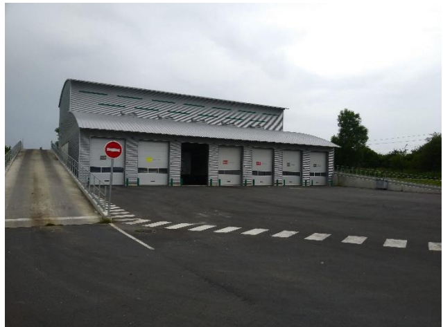
Emplacement des FMA en contrebas
